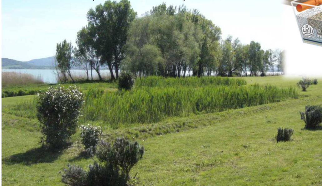
Fitodepurazione HF da 100 a.e. Isola di Polvese (L. Trasimeno, PG)
