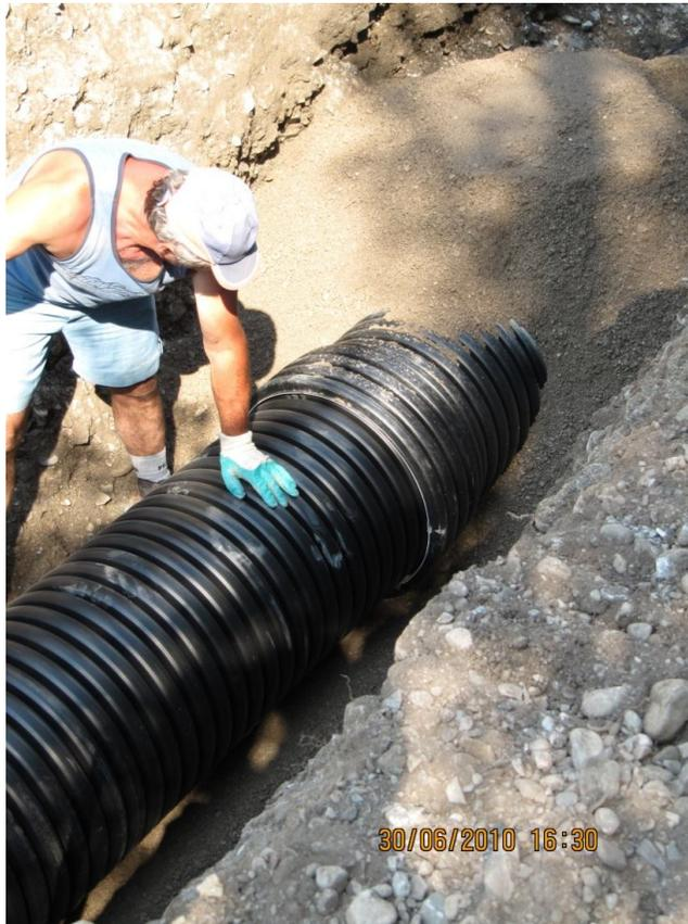
Grazie all'ottima rigidità ed alla buona resistenza all'impatto, a cui vanno aggiunte l'eccellente resistenza chimica ed alle temperature medio-alte, il polipropilene risulta essere un materiale particolarmente idoneo per la realizzazione di tubazioni di scarico, sia civili che industriali.
